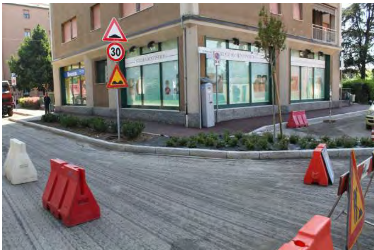
ABBATTIMENTO BARRIERE ARCHITETTONICHE E RIFACIMENTO TRATTI DI STRADE E MARCIAPIEDI
